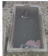
**Conseils d'entretien :** une vidange des graisses accumulées tous les 3 à 6 mois en fonction de l'utilisation. Vérifier la bonne ventilation de l'ouvrage.
