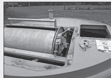
Domages causés à l'un des points d'apports situés au parking de la Banège
