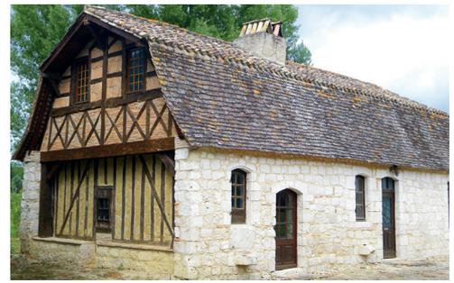
**Le pan de bois** : Mêlant ossature en bois et remplissage en torchis ou en pierres, recouverte d'un enduit, cette technique se retrouve sur de nombreuses maisons situées sur la commune de Ste Radegonde tel qu'à Issigeac.
